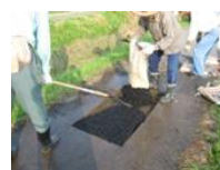
農道の部分補修
