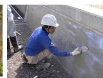
老朽化した水路壁のコーティング
