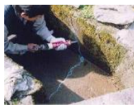
水路のひび割れ補修
