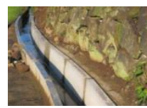
コンクリート水路への更新
